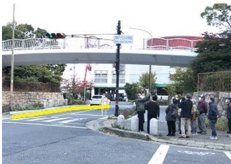
④サンライズゲート橋下道路
