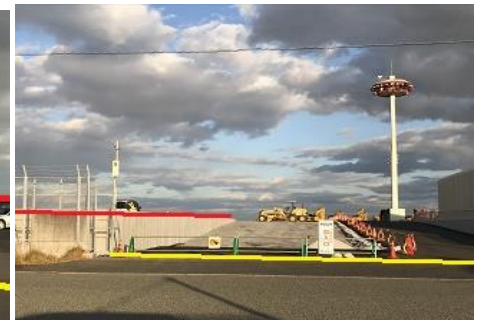
⑥東側埠頭の嵩上げ工事
